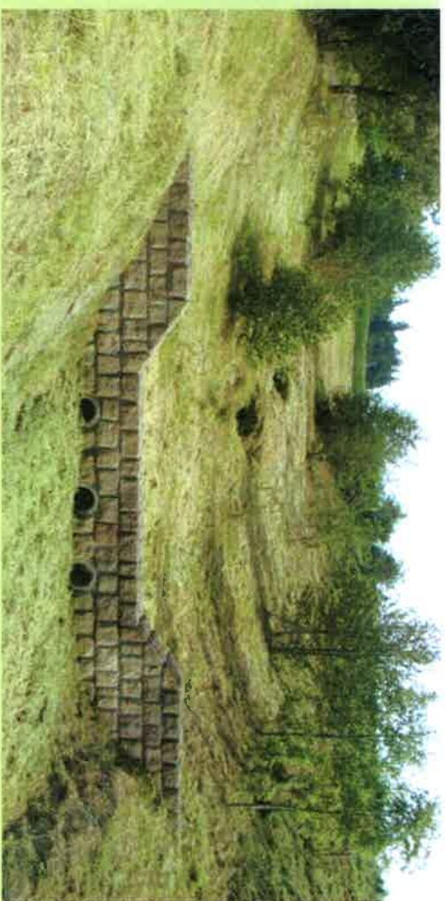
Stabilizační přehrážka v k.ú. Líčnov
