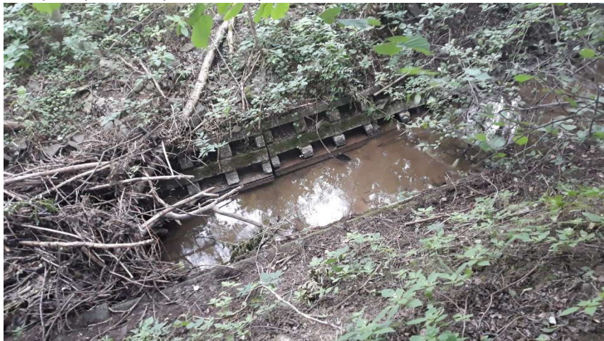
1. Koryto opevněno prefabrikáty
