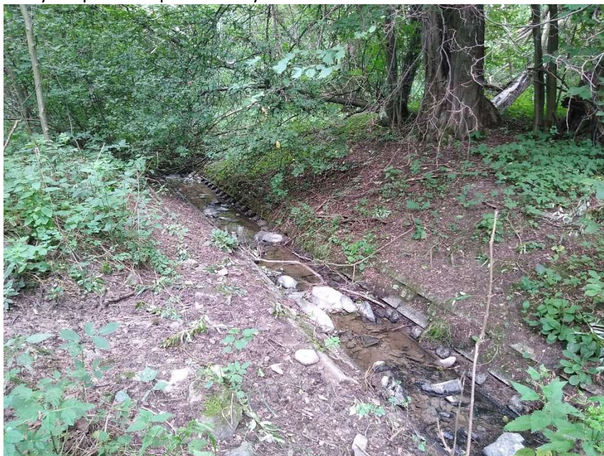
2. Koryto opevněno prefabrikáty
