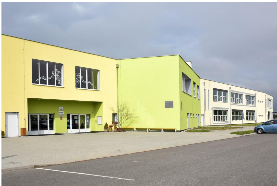
Budova školy, Pražská 800
